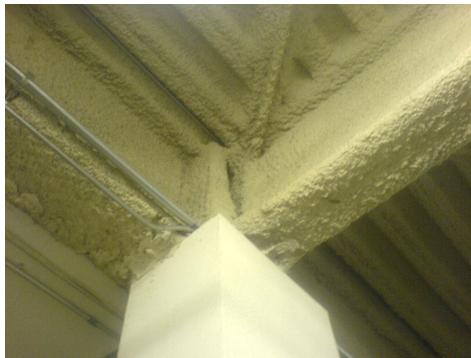
Spritzisolierung als Brandschutz - in diesem Fall ohne Asbest (neueren Datums)
