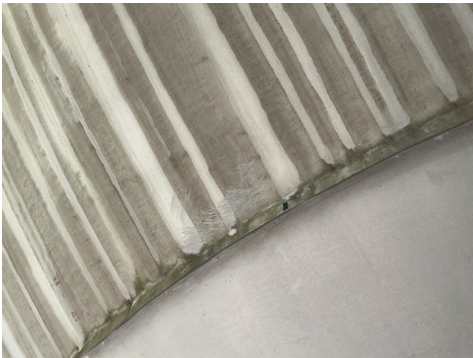
Anstrich an einem Gashochdruckspeicher, TFB Technik und Forschung im Betonbau
