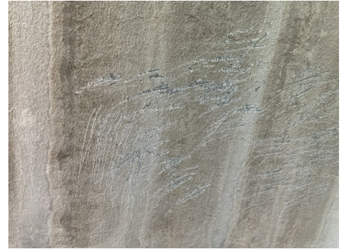
Anstrich an einem Gashochdruckspeicher, TFB Technik und Forschung im Betonbau
