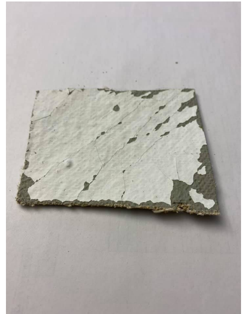
Stramin Wandbelag mit Asbest im Anstrich und Kleber, Solgeo
