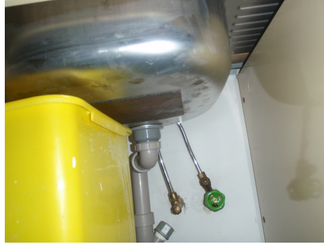
Bitumenplatte zum Dröhnschutz unter Lavabo/Spühlbecken (hier ohne Asbest).
