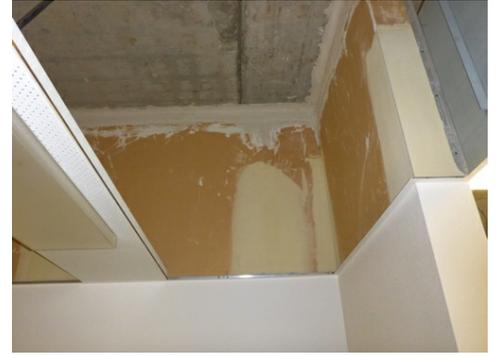
Photo d'enduit avec amiante
