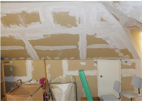
Enduit sur du plâtre cartonné avant crépissage (ici, non amiante). Photo de Carbotech AG
