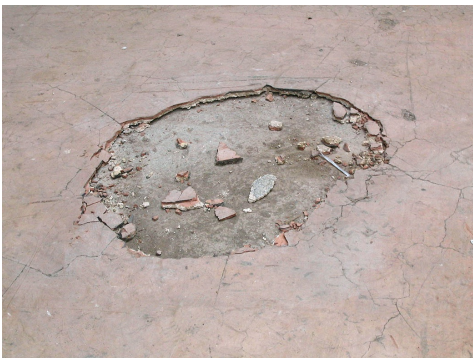
Chape à base de magnésite, Suva
