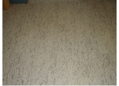
Revêtement de sol, Suva
