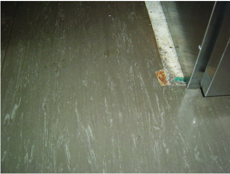
Revêtement de sol, Suva
