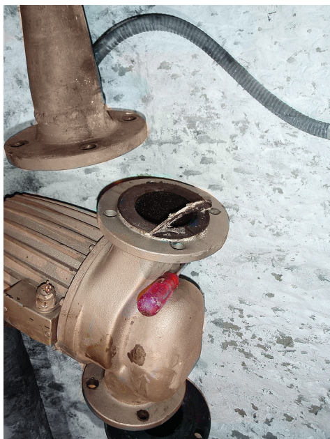
Reste d'un joint d'étanchéité. Si ces restes sont poncés, il y a un risque de libération importante de fibres d'amiante (Photo: Carbotech AG)
