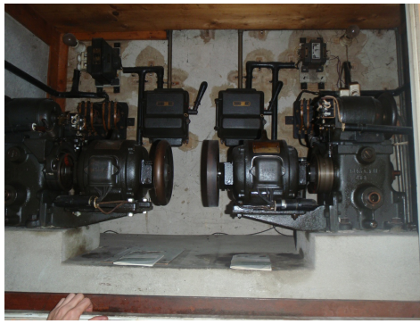
Photo moteur monte / monte charge dans restaurant. Les plaquettes de frein sont potentiellement amiantés.
