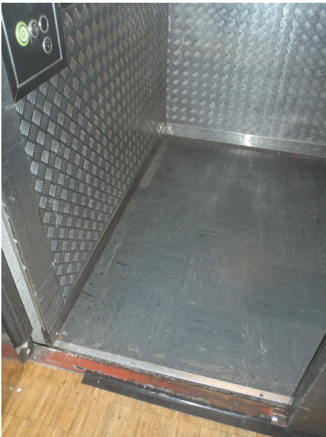
Monte-charge avec revêtement de sol en dalles de vinyle (ici non amiantées).
