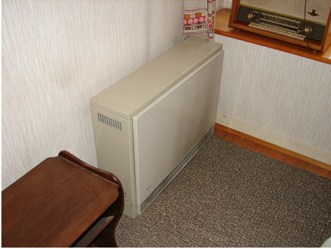
Chauffage électrique à accumulation de la marque AEG, Carbotech
