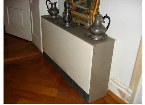
Chauffage électrique à accumulation, Carbotech
