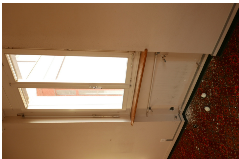
Enduit dans une niche de chauffage, SCS
