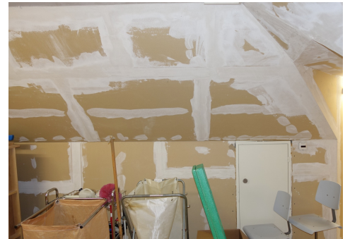
Enduit sur du plâtre cartonné avant crépissage (ici, non amiante). Photo de Carbotech AG
