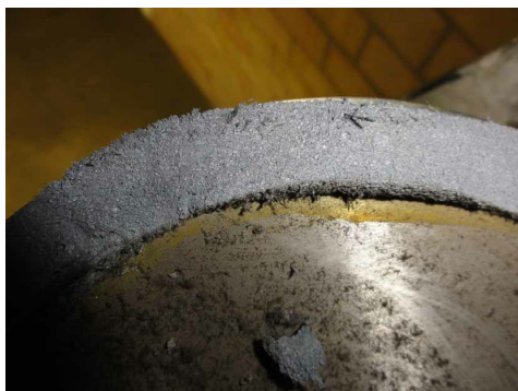
Détail: Litaflex comme protection anti-feu autour d'un tube de chauffage. Photo: Carbotech AG
