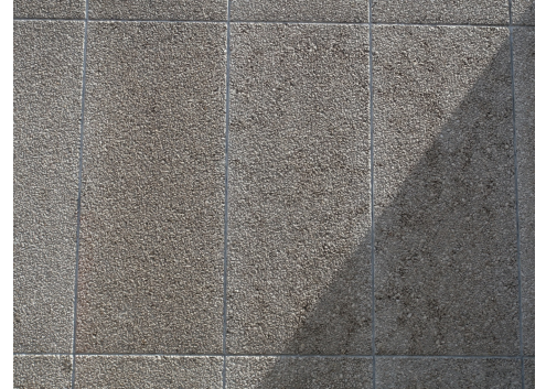
Masse d'étanchéité des joints, béton lavé, Gebäuediagnostik Siegart
