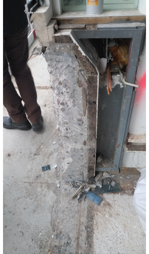
Liège goudronné dans façade, SCS
