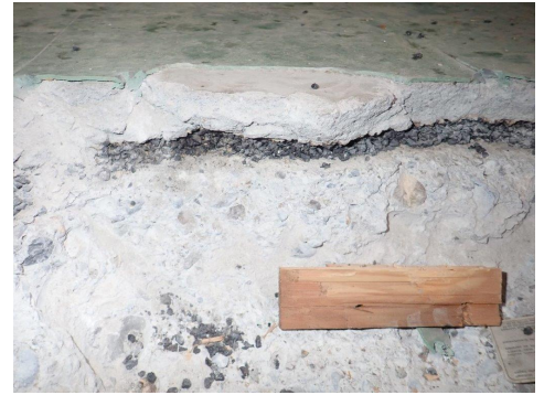
HAP en remblayage sous chape, Gartenmann Engineering
