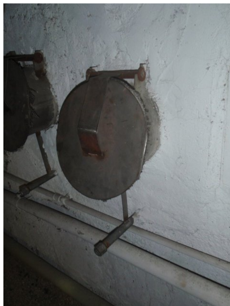
Bocchette d'ispezione del condotto dei
