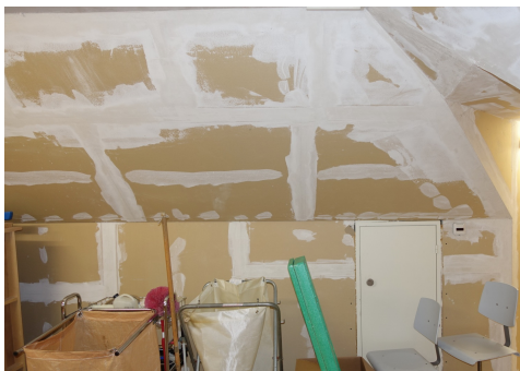
Sigillatura delle lastre in cartongesso prima dell'intonacatura, in questo caso priva di amianto. (Foto Carbotech AG).
