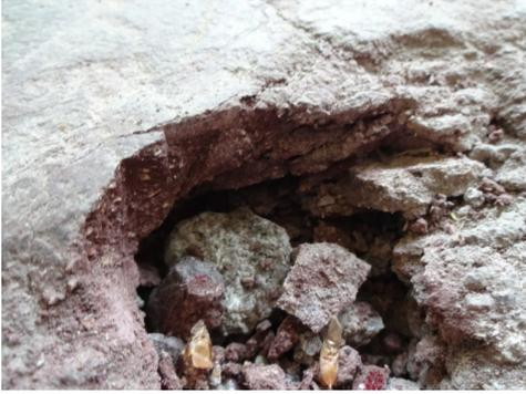
Pavimento in legno-cemento contenente amianto.
