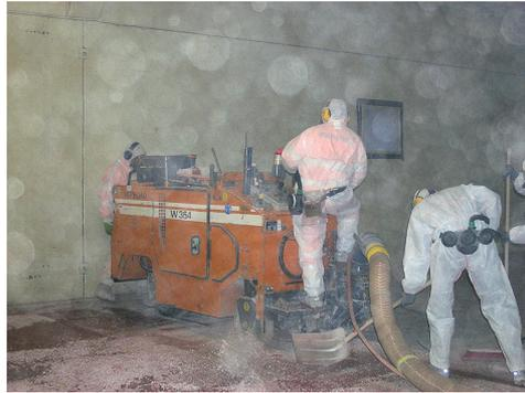
Rimozione del massetto in magnesite, Suva
