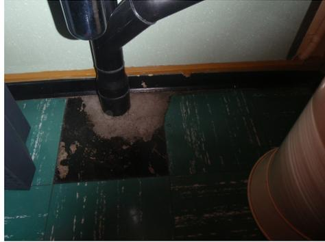
Rivestimenti per pavimenti in piastrelle viniliche, compreso l'adesivo sottostante, contenenti amianto.
