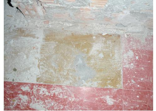
Adesivo non bituminoso del rivestimento: vinilico questo materiale è suscettibile di contenere amianto.
