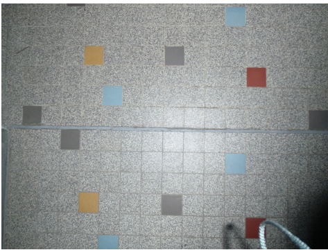
Giunti tra piastrelle: oltre agli adesivi contenenti amianto, in alcuni casi è possibile incontrare giunti suscettibili di contenere PCB.
