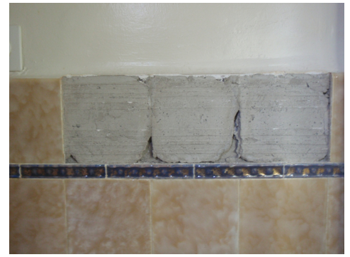
Secondo lo stato attuale delle conoscenze, normalmente la malta utilizzata per l'incollaggio puntuale delle piastrelle con la tecnica di posa "dot and dab tiling" NON contiene amianto. Essa viene ispezionata solo in casi eccezionali.
