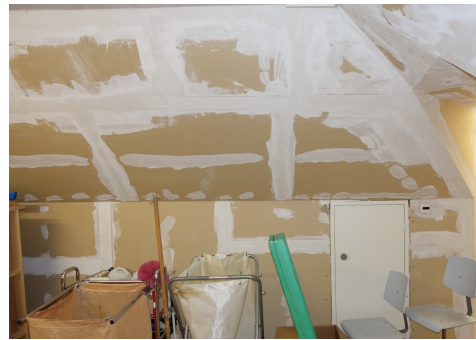
3. Stuccature delle giunzioni tra elementi in cartongesso. (in questo caso senza amianto). (Foto Carbotech AG)
