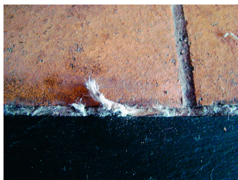
Corda di amianto in un caminetto
