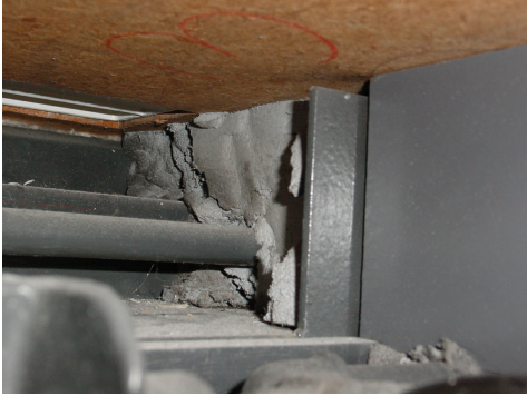
Litaflex® come compartimentazione antincendio per tubazioni da riscaldamento. (Foto: Carbotech AG)
