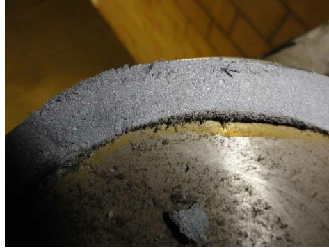
Immagine di dettaglio di una schiuma Litaflex® applicata su un tubo di riscaldamento. (Foto: Carbotech AG)
