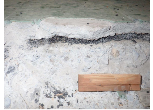
Riempimento di IPA sotto il massetto, Gartenmann Engineering
