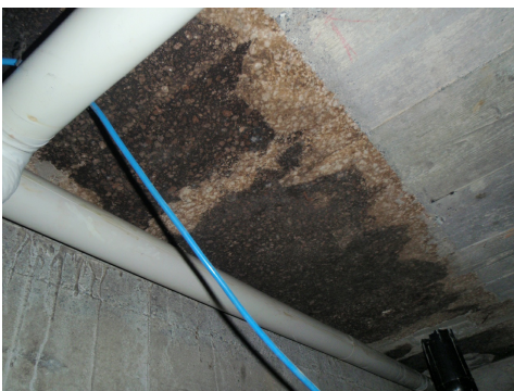
Isolamento in sughero bituminoso (ponte termico). L'isolamento è stato posato nel cassero della soletta prima del getto del calcestruzzo.
